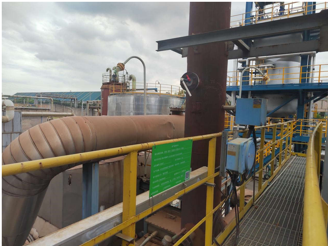
图 2-2 第二污水场储罐异味治理项目现场照片
