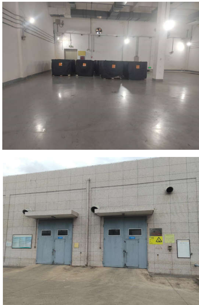
图 3-5 依托厂区现有危废暂存间现场照片
