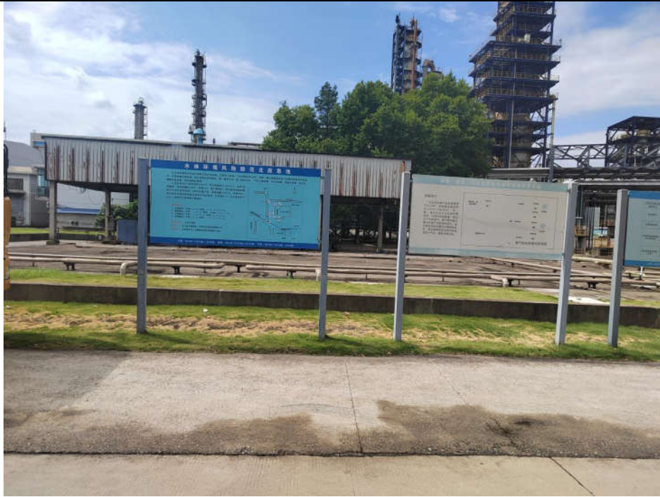
图 3-7 依托厂区现有西、北应急池现场照片
