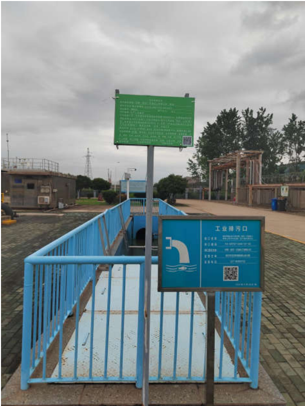
图 3-1 依托厂区现有污水处理厂及总排口现场照片
