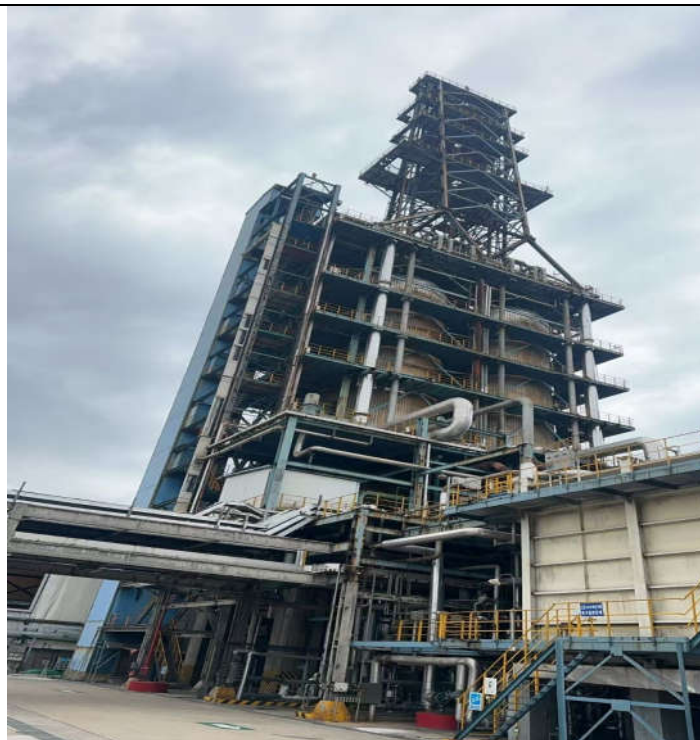
图 3-3 依托厂区现有 2#焦化装置区域密闭除焦系统现场照片
