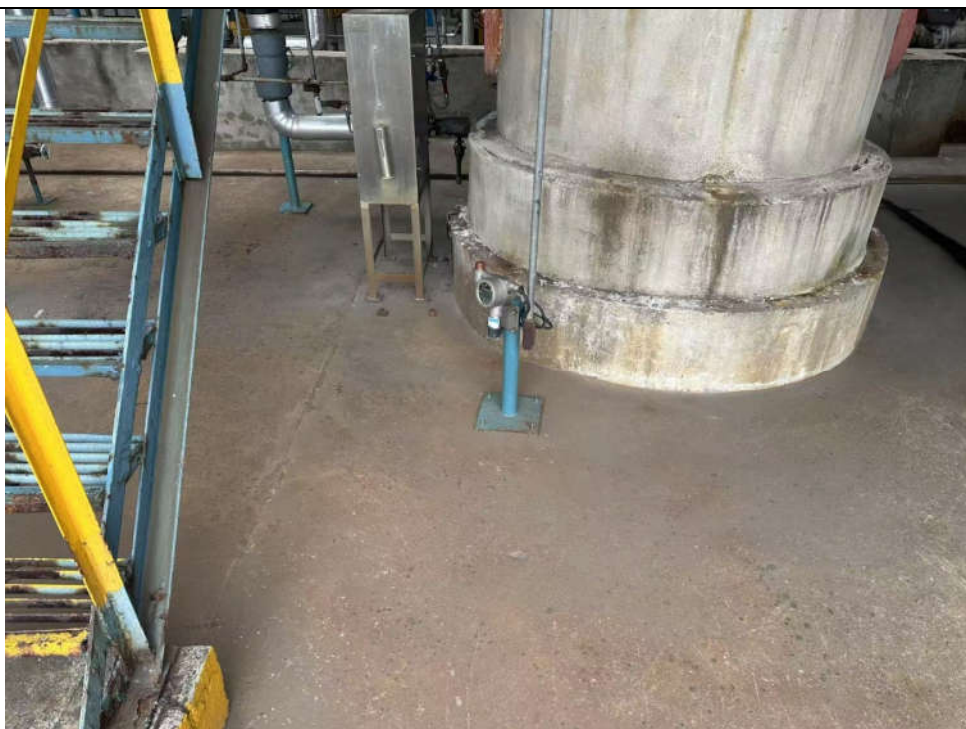
图 3-6 固废综合利用场地可燃气体浓度报警装置现场照片
