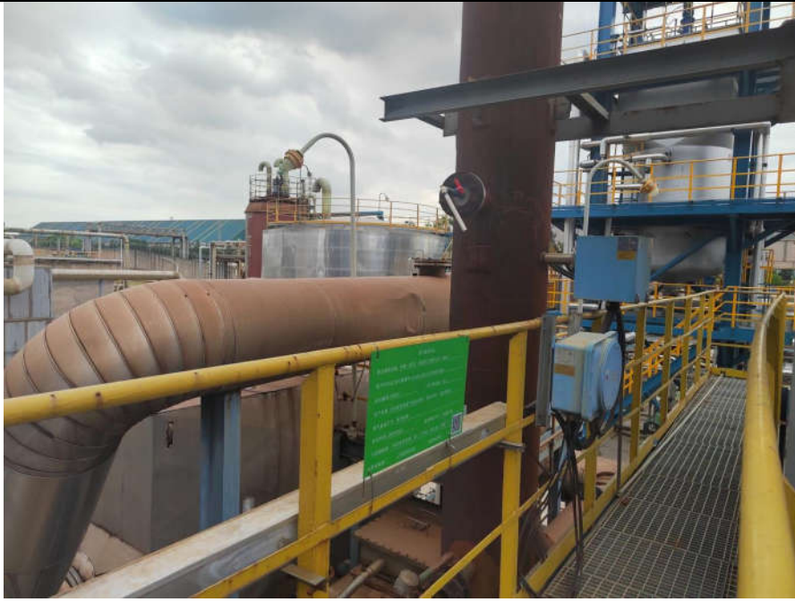
图 3-4 依托厂区现有第二污水场催化氧化设施现有排气筒现场照片
