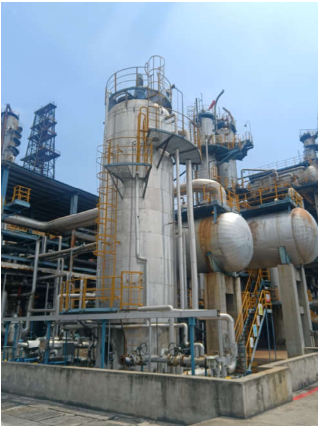
图 2-1 固废综合项目利用场地现场照片
