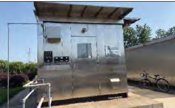
东雨水排口在线站房（原高浓度雨水排口）
