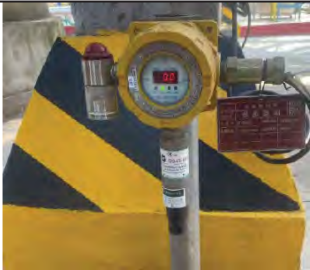
3#气分装置毒性气体探测器
