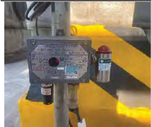
3#气分装置可燃气体探测器
