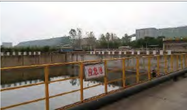
高浓度污水处理场应急池
